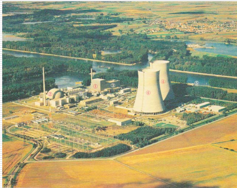
Das Kernkraftwerk Philippsburg besteht aus den beiden Reaktorblöcken 1 und 2. Deutlich zu sehen sind jeweils die Kuppel des Siedewasserreaktors ① und des Druckwasserreaktors ②, die Turbinen- und Generatorenhäuser ③, die Kühltürme ④ und die Kühlwassereinleitung in den Rhein ⑤.
